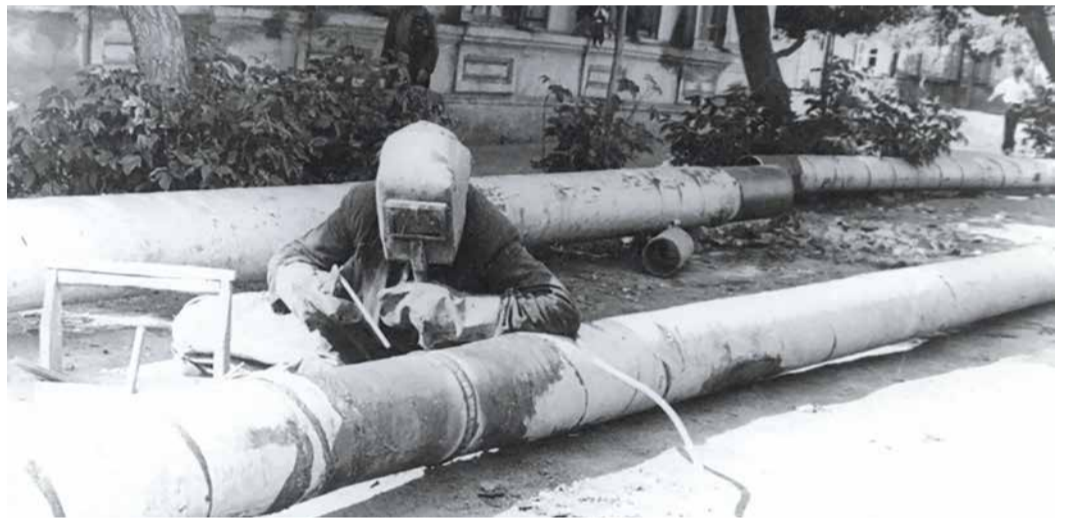
Сварка газопровода на ул. Чернышевского в Уфе, 1953 г.
