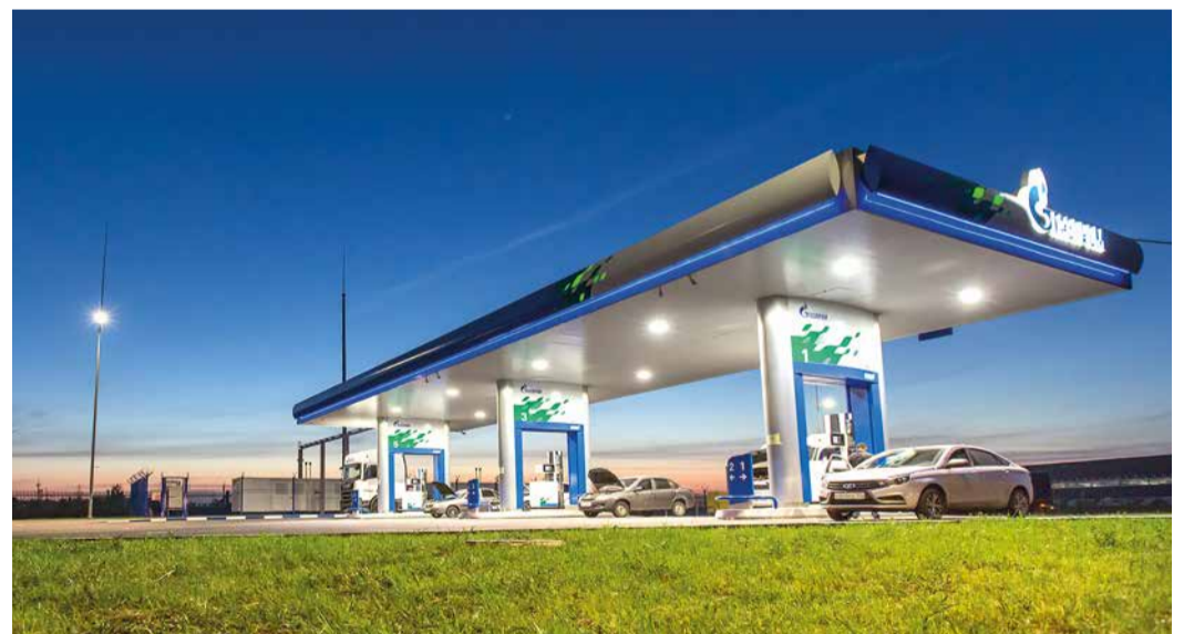
В регионе к началу 2023 года функционирует 51 метановая станция
